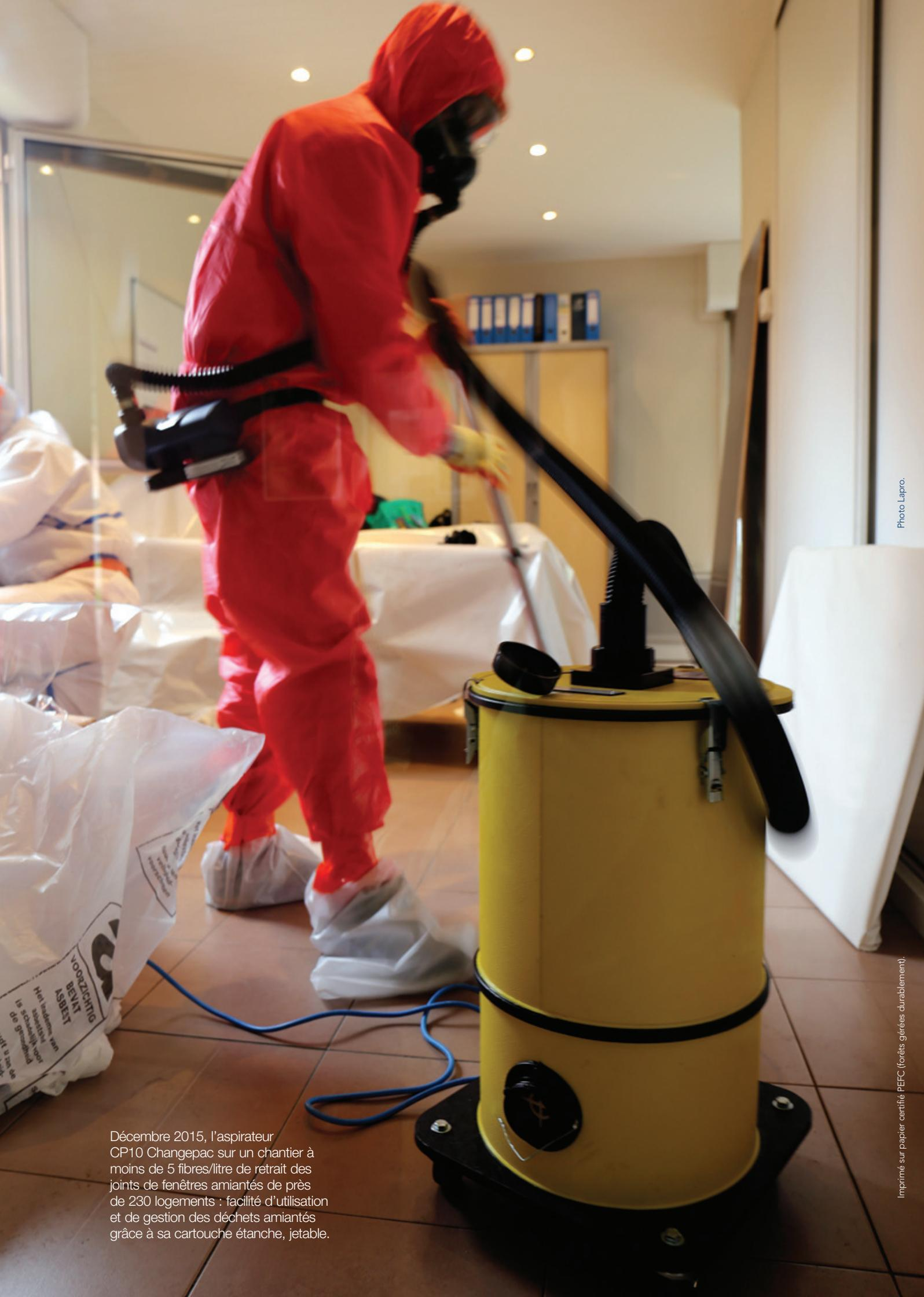
Décembre 2015, l'aspirateur CP10 Changepac sur un chantier à moins de 5 fibres/litre de retrait des joints de fenêtres amiantés de près de 230 logements : facilité d'utilisation et de gestion des déchets amiantés grâce à sa cartouche étanche, jetable.
