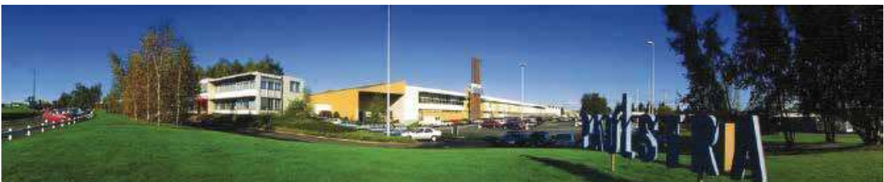
Usine de Segré (Maine-et-Loire) - ISO 9001
