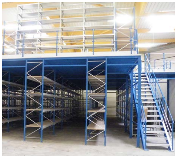
Plate-forme sur rayonnage Epsivol. Ad'vance à l'étage.
