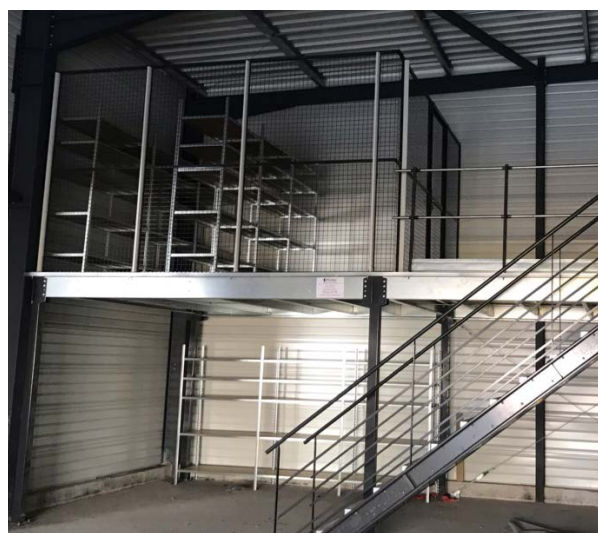
Délimitation du rayonnage Ad'vance par de la cloison industrielle, accessible sur une plate-forme Mezzaman Stock.
