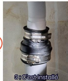
Raccords multimatériaux de **connexion** et de **réparation** en acier inox AISI 304 et joint en EPDM. Ils résistent aux températures entre - 40°C et + 140°C et la tenue au feu est de **classe E**.
