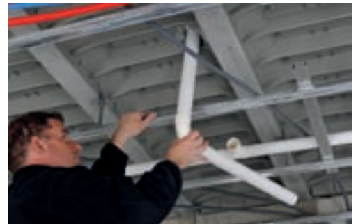
Traversée de dalle (R vers R+1)
