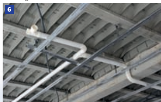
Montage en faux plafond
