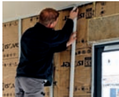
Montage en doublage
