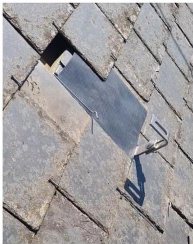
Mettre une bande d'étanchéité de type Wakaflex avant de positionner le crochet
