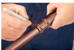
4. Assemblage et marquage de la profondeur d'insertion
