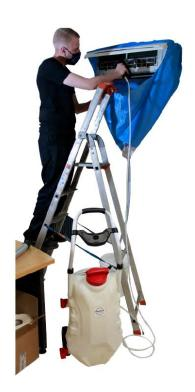
Une gamme complète de bâche de protection réutilisable, équipée de leur système de fixation, d'une évacuation des résiduels de nettoyage et d'un seau de récupération.
