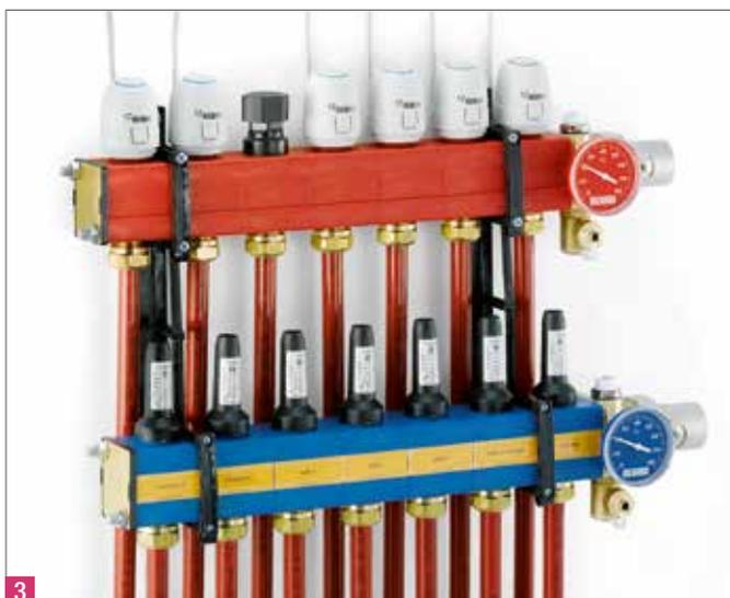
**Exemple** : débit souhaité 145 l/h. Tourner le débitmètre jusqu'à ce que le repère rouge à l'intérieur du débitmètre atteigne le niveau 3, voir équivalence niveau l/h sur le capuchon du débitmètre.
