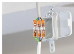
Raccordement de luminaires dans les faux-plafonds
