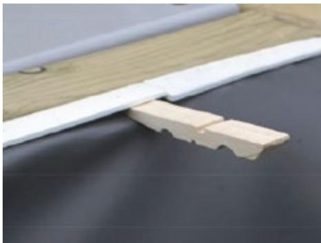
Figure 32 – Verrouillage du liner grâce à des demi épingles à linge
