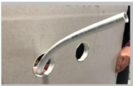
Percer 2 trous à l'aide d'une scie cloche diam.60mm pour le passage des tuyaux multicouches ou PER en veillant à maintenir une ligne correcte.
