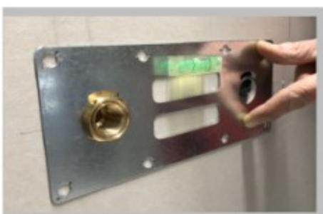
Fermer le contre-écrou sans trop serrer. A l'aide du niveau à bulles installé sur la plaque, mettre en ligne et marquer la position correcte des trous pour l'installation des chevilles fournies.
