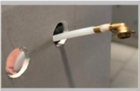
Installer les coudes en laiton à glissement pour tubes PER.
