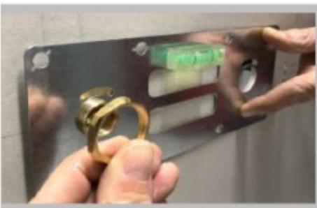
Fixer le coude laiton avec le contre-écrou en vérifiant que la goupille anti-rotation soit bien insérée dans le guide de la plaque galvanisée.
