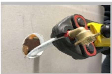
Procéder au sertissage dans la version « à sertir » en prenant soin d'utiliser les outils indiqués dans la fiche technique et en faisant attention à monter les mâchoires correctement que la sertiteuse (Multiprofil TH-H-U pour les tubes multicouches et H, RF sur tubes PER)
