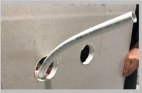
Percer 2 trous à l'aide d'une scie cloche diam.60mm pour le passage des tuyaux PER en veillant à maintenir une ligne correcte.
