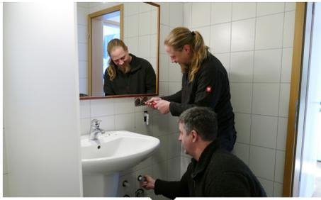
En cas de rénovation, commencer le démontage (couper les raccords existants et l'arrivée d'eau, les fusibles doivent être éteints).
