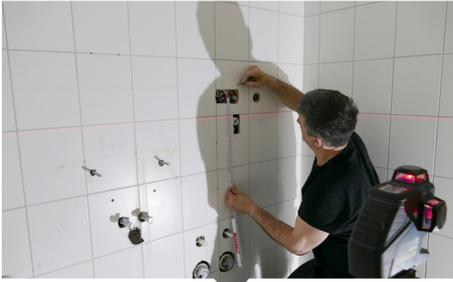
Déterminer toutes les dimensions nécessaires à la découpe des panneaux VIPANEL®.
