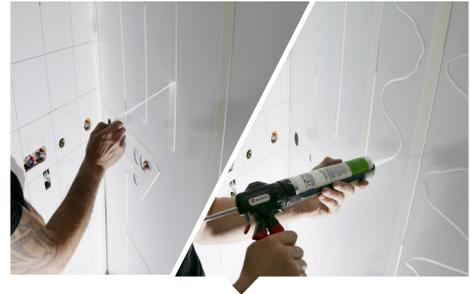
Pour le collage durable des panneaux, appliquer la colle en cordon à l'arrière du panneau. Compter environ 1 cartouche de 290ml pour une plaque de 2.55 x 1.5m.
