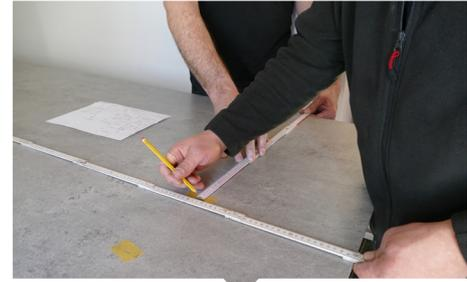
Transférer les dimensions déterminées sur les panneaux. Pour les ouvertures, marquer le centre de perçage.
