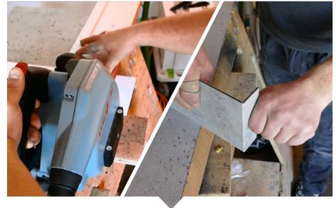
**Angle sans profilé :** il est possible de réaliser une rainure à l'arrière des panneaux grâce à une fraiseuse à rainure trapézoïdale. Les panneaux peuvent ainsi être pliés pour une pose sans profilé.
