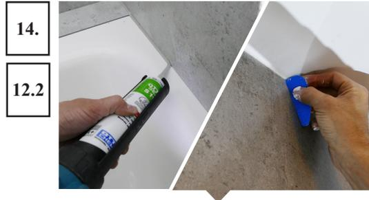
Appliquer du silicone aux pourtours des panneaux pour assurer l'étanchéité. Lisser et retirer le surplus de silicone.
