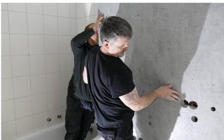
Avant de fixer le panneau effectuer un montage à blanc en utilisant des cales de 3mm sous les panneaux, assurez-vous qu'il est parfaitement ajusté au mur.
