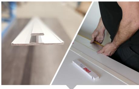
**Pose avec profilé :** Appliquer un filet de silicone dans la gorge du profilé (sur toute sa hauteur) puis insérer le profilé sur le panneau.
