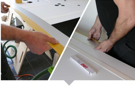
**Pose bord à bord :** afin de garantir une jonction uniforme et étanche entre les panneaux il est obligatoire de fixer une bande métallique (PM BME 0103001) avec un adhésif double face. A appliquer sur toute la hauteur sur chaque bord de la bande. Pour une pose bord à bord de meilleure qualité, faire une découpe à blanc avec la scie sur toute la hauteur du panneau.
