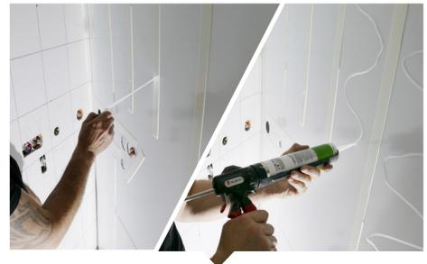
Pour le collage durable des panneaux, appliquer la colle en cordon à l'arrière du panneau. Compter environ 1 cartouche de 290ml pour une plaque de 2.55 x 1.5m.
