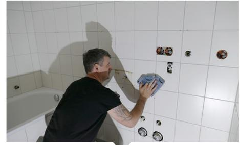
En neuf ou en rénovation, le support doit être étanche, stable, uniforme, sain et sec. Appliquer un primaire sur les supports fortement absorbants tels que les panneaux de fibres de plâtre ou de gypse. Nettoyer le support avec un dégraissant.
