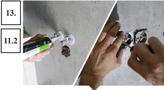
Comblent les ouvertures avec du silicone.
